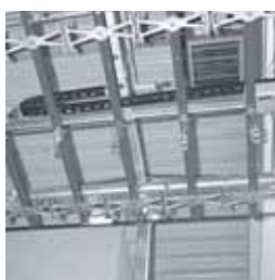
Impianto di distribuzione impregnante per finestre
