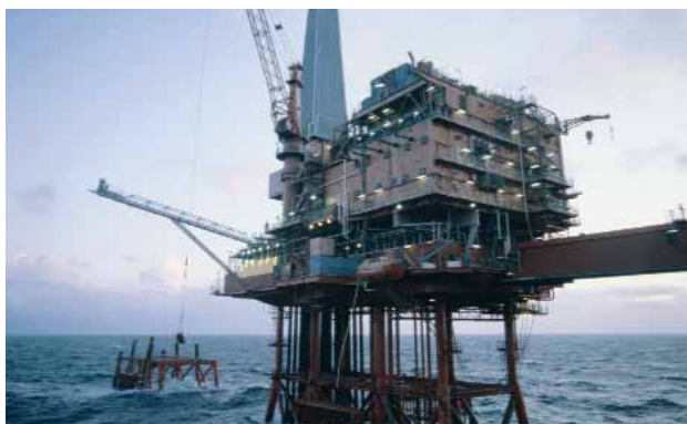
iglidur® G e DryLin® N in un'apparecchiatura di controllo su una piattaforma offshore
